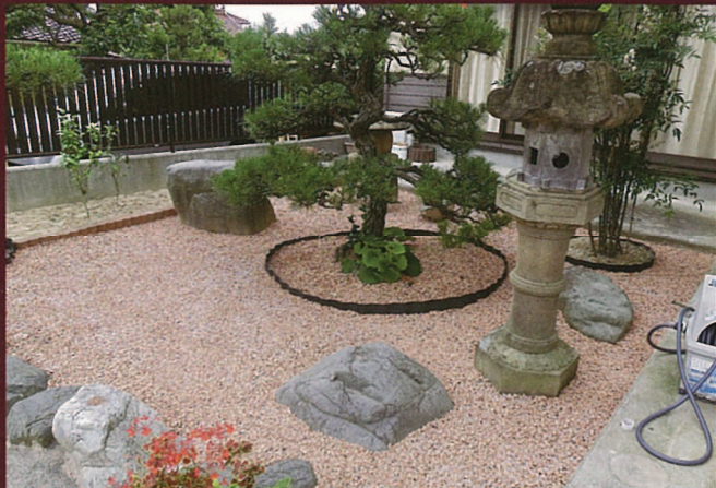
●純日本家屋庭園への施工例（防草対策施工）
