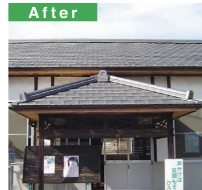
和形スレート瓦をいぶしの平板に棟積みすることで新和風の味を出します。
