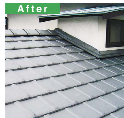
洋風スレート瓦をいぶしの平板瓦にすることで高級感を醸し出します。
